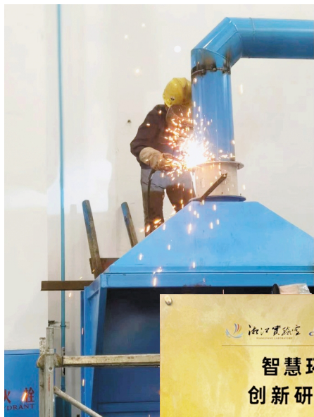
▲ 航天凯天环保焊接工人在施工。
