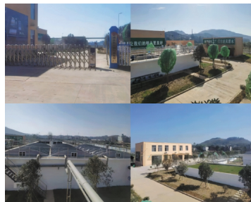
图 2 溆浦县低庄镇污水处理厂实景图
