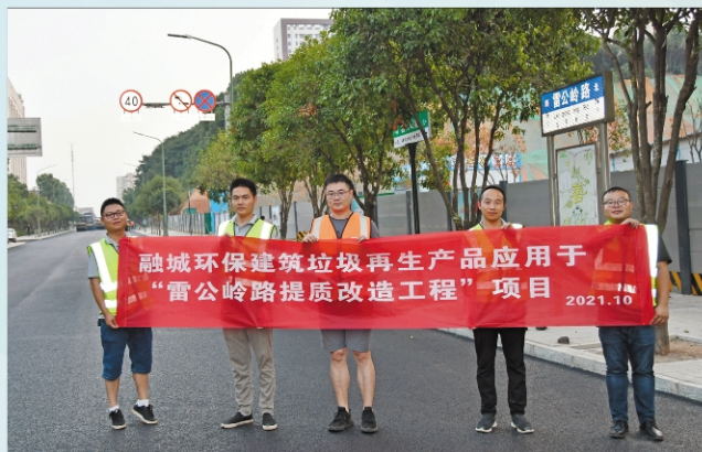
长沙县雷公岭路提质改造工程
