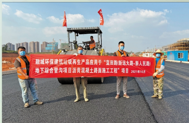
长沙经开区蓝田路沥青路面工程
