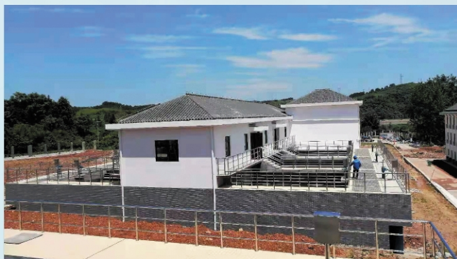
芷江侗族自治县沅州新能源第二水厂
