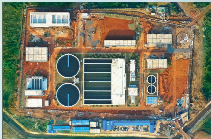
株洲市建宁港金山污水处理厂
