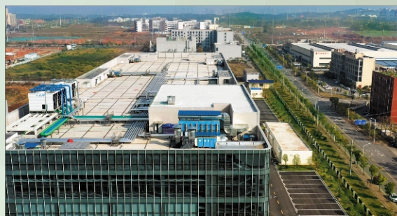
盈准科技SMT废气处理工程
