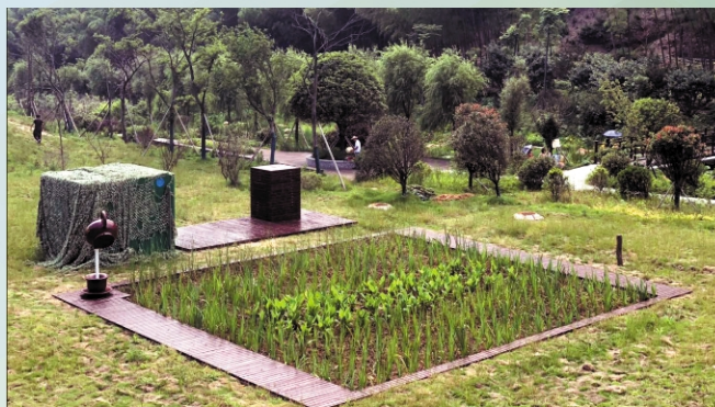
影珠山景区生活废水处理工程
